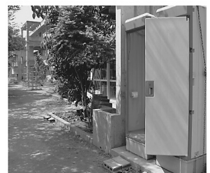
外に設置の仮設トイレ
