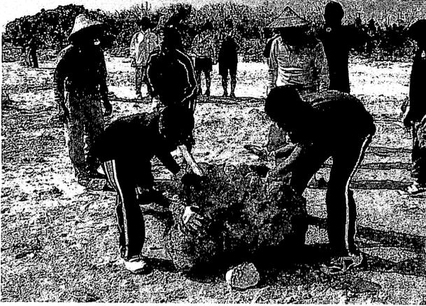
写真1 テコを使った石の運搬
